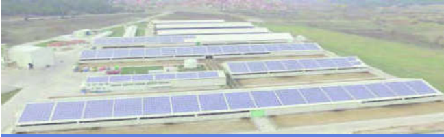
ÇATI ÜZERİ FOTOVOLTAİK GES 2016
