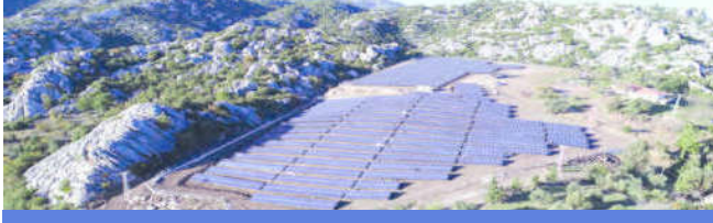
ARAZİ ÜZERİ FOTOVOLTAİK GES 2017
