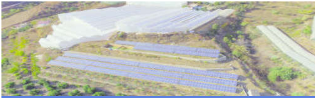
ARAZİ ÜZERİ FOTOVOLTAİK GES 2013
