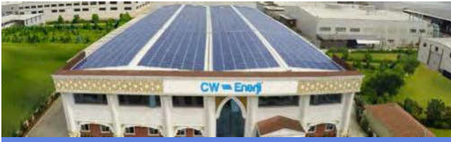
ÇATI ÜZERİ FOTOVOLTAİK GES 2017
