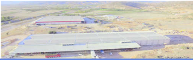
ÇATI ÜZERİ FOTOVOLTAİK GES 2014
