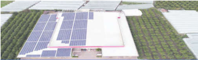
ÇATI ÜZERİ FOTOVOLTAİK GES 2017
