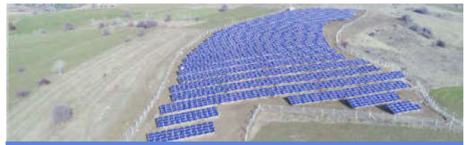
ARAZİ ÜZERİ FOTOVOLTAİK GES 2017
