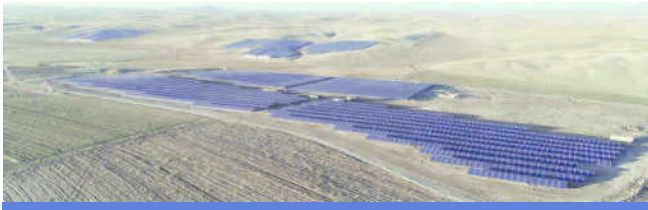
ARAZİ ÜZERİ FOTOVOLTAİK GES 2017
