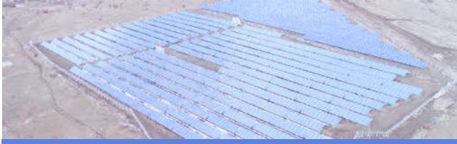
ARAZİ ÜZERİ FOTOVOLTAİK GES 2017
