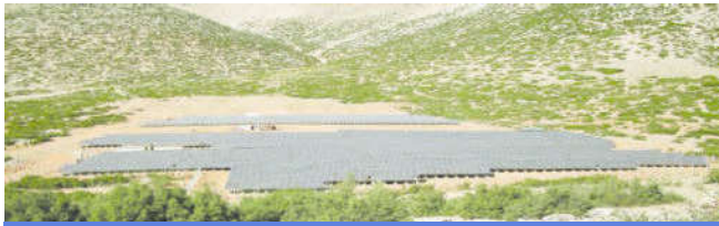
ARAZİ ÜZERİ FOTOVOLTAİK GES 2016
