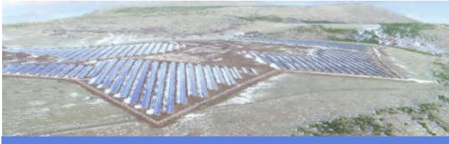
ARAZİ ÜZERİ FOTOVOLTAİK GES 2017
