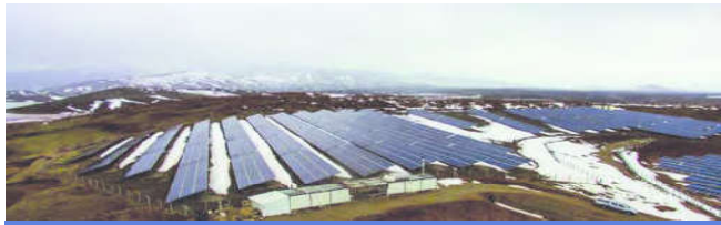
ARAZİ ÜZERİ FOTOVOLTAİK GES 2015
