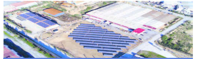
ARAZİ ÜZERİ FOTOVOLTAİK GES 2017
