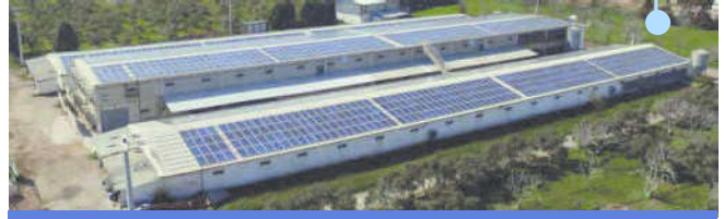
ÇATI ÜZERİ FOTOVOLTAİK GES 2015
