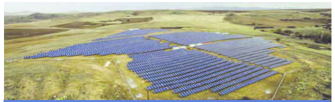
ARAZİ ÜZERİ FOTOVOLTAİK GES 2016
