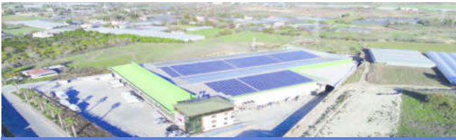
ÇATI ÜZERİ FOTOVOLTAİK GES 2017
