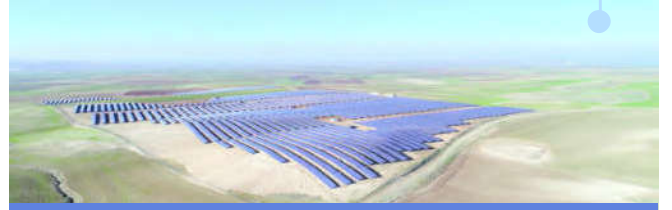
ARAZİ ÜZERİ FOTOVOLTAİK GES 2017
