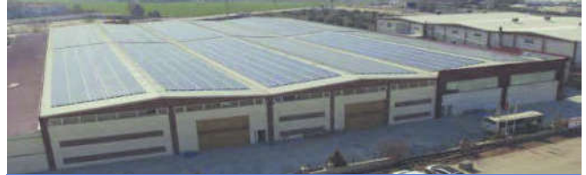
ÇATI ÜZERİ FOTOVOLTAİK GES 2017
