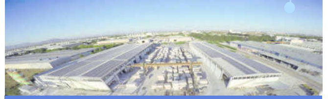
ÇATI ÜZERİ FOTOVOLTAİK GES 2016
