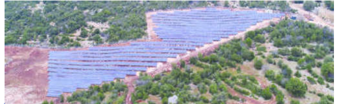
ARAZİ ÜZERİ FOTOVOLTAİK GES 2017
