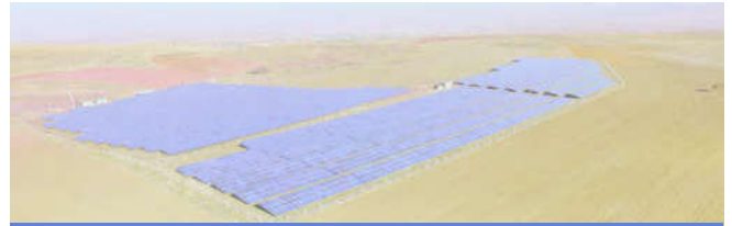
ARAZİ ÜZERİ FOTOVOLTAİK GES 2017
