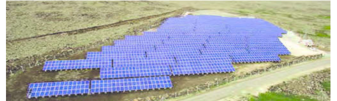
ARAZİ ÜZERİ FOTOVOLTAİK GES 2017
