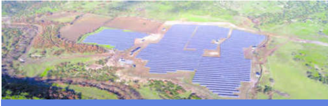
ARAZİ ÜZERİ FOTOVOLTAİK GES 2017
