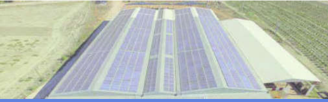
ÇATI ÜZERİ FOTOVOLTAİK GES 2014
