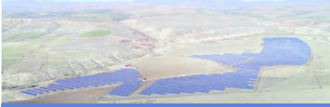
ARAZİ ÜZERİ FOTOVOLTAİK GES 2017
