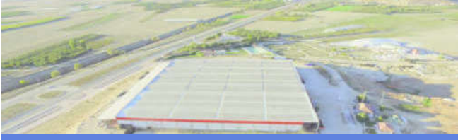
ÇATI ÜZERİ FOTOVOLTAİK GES 2015
