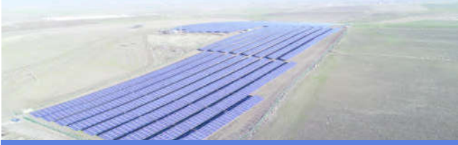
ARAZİ ÜZERİ FOTOVOLTAİK GES 2017
